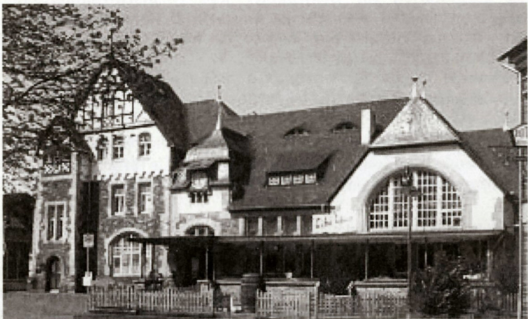
Bahnhof Bernkastel-Kues, Endstation der Stichbahn von Wengerohr aus
